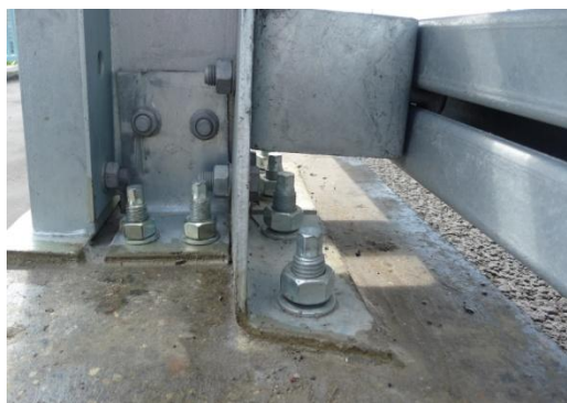
Крепление барьерных ограждений Клеевая капсула V-P, шпилька V-A
