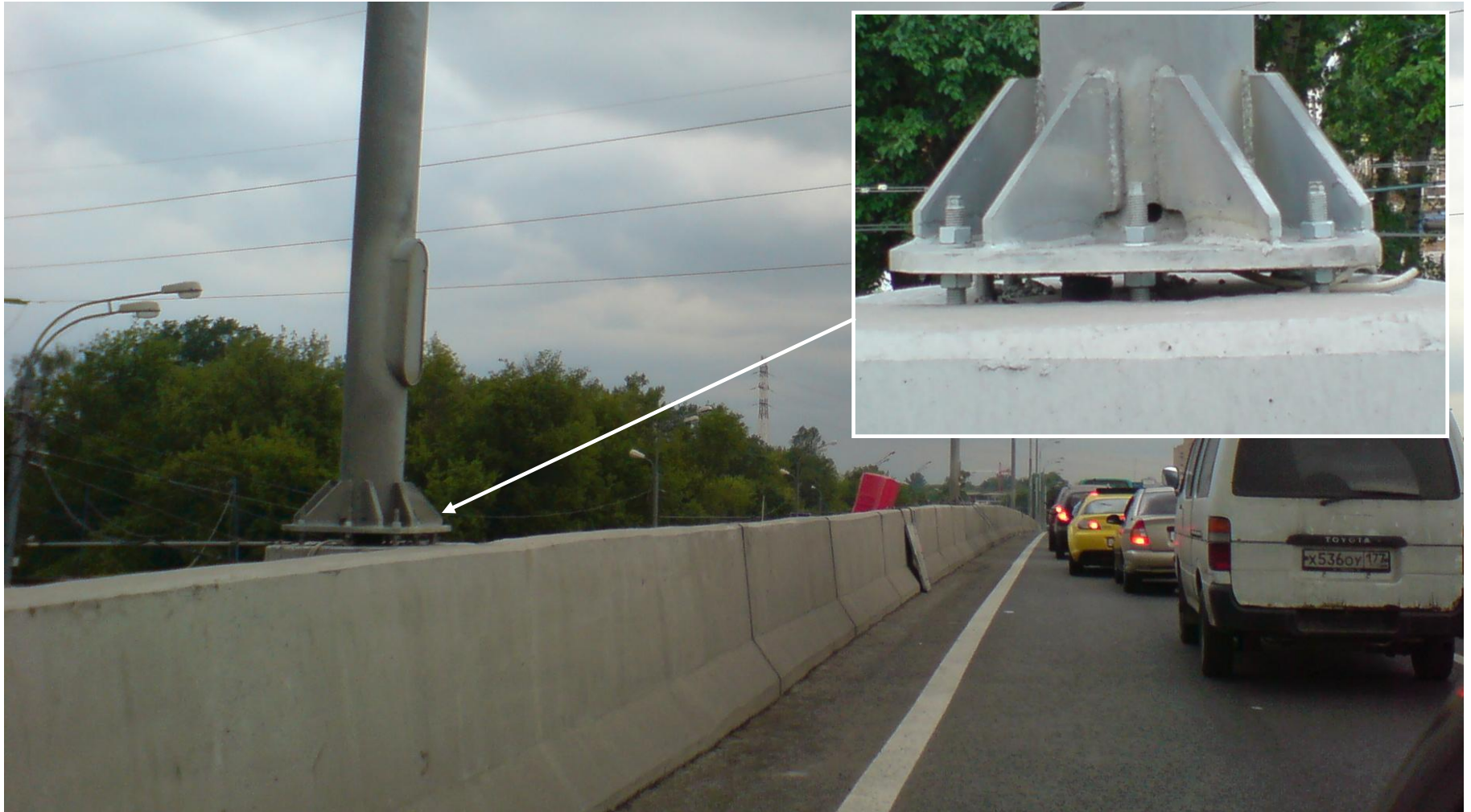
Крепление мачт освещения Клеевая капсула V-P 20, шпилька V-A 20x300
